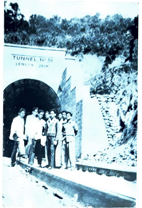
D. B. K. Railway Tunnel (G. V. N. Narasimham)
